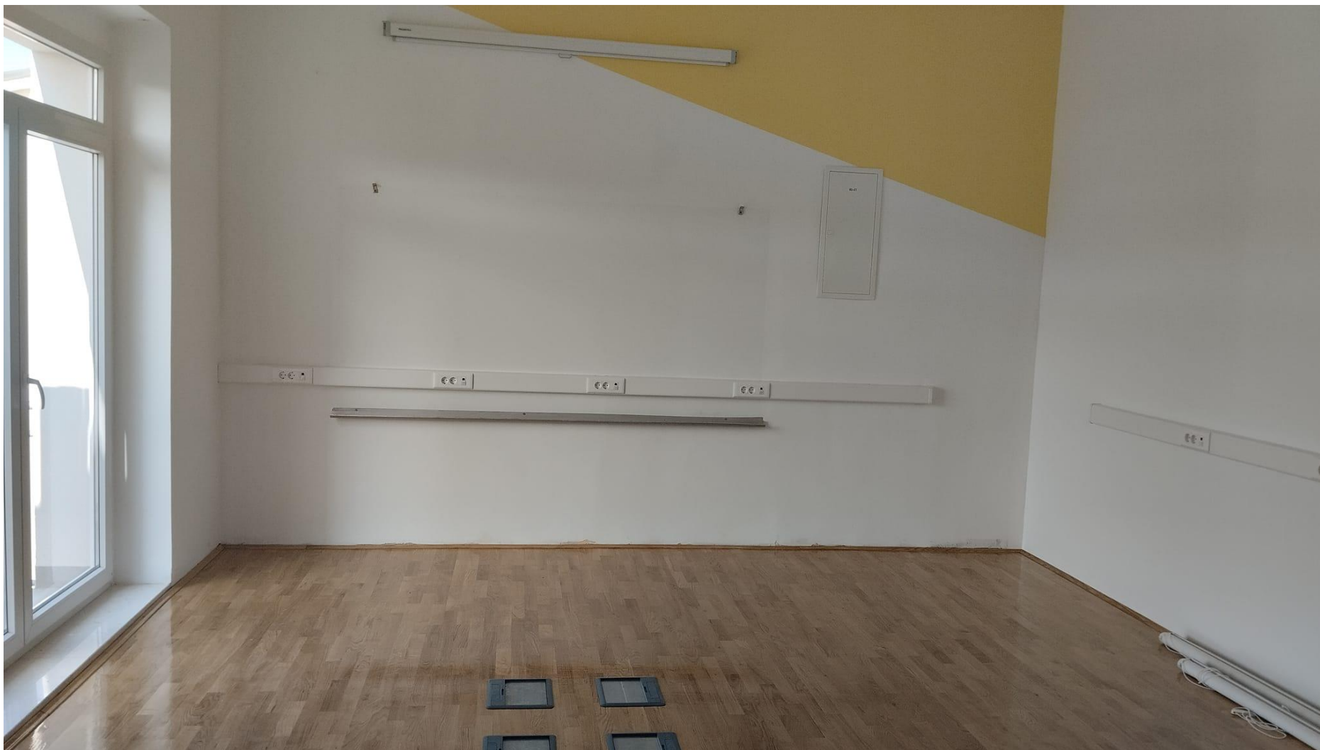
Obnova učionice u sklopu projekta STEM COUNTY
